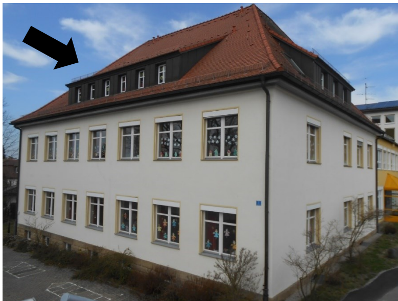
Horträume im Dachgeschoss der Grundschule
