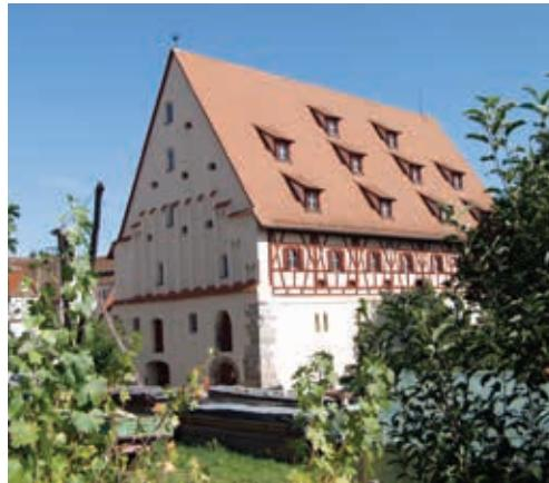
ein Fachwerkgeschoss aufgesetzt wurde. Der Giebel des Erweiterungsbaus ragt vom dritten Stockwerk an 15 Meter frei in die Höhe. Der Dachstuhl ist ein „liegender Dachstuhl“, eine mittelfränkische Eigentümlichkeit.
