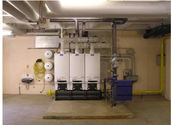
Heizkesselanlage nachher
